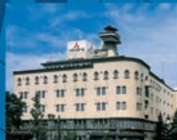
本店ビル（東京都中央区）
