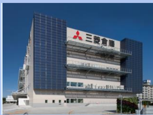
三菱倉庫 茨木3号配送センター
