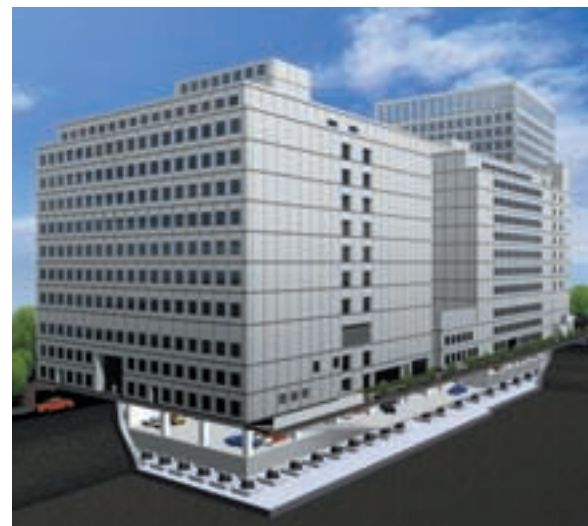
東京ダイヤビル1～4号館の免震構造
