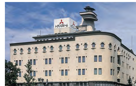
江戸橋倉庫ビル
