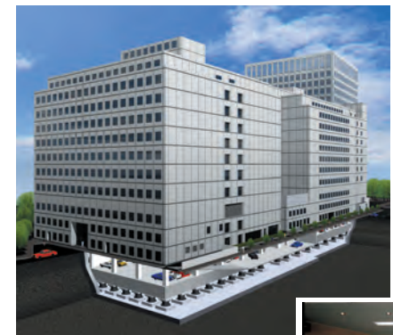
東京ダイヤビル 1~4号館の免震構造
