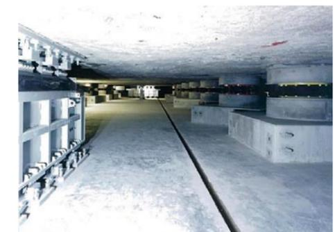
免震装置(積層ゴムおよび粘性体ダンパー)
