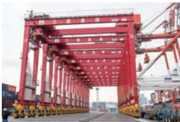
トランスファークレーン
