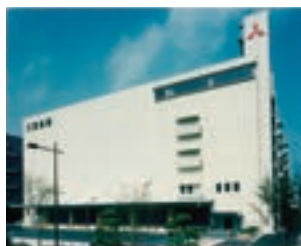
福岡支店中央埠頭倉庫
