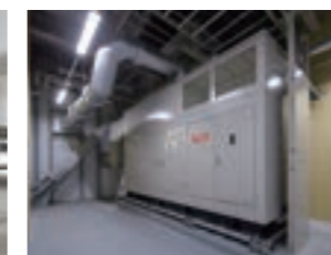
非常用発電装置 (横浜・南本牧配送センター)
