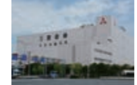
1999年 自動倉庫(大井冷蔵倉庫)
