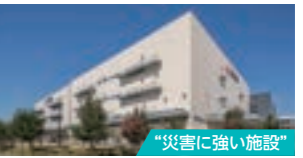
2020年10月 埼玉・三郷2号配送センター2期棟竣工
