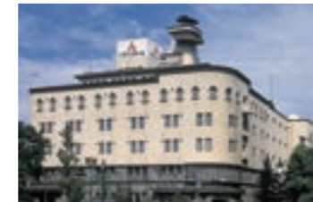
1930年 江戸橋倉庫ビル
