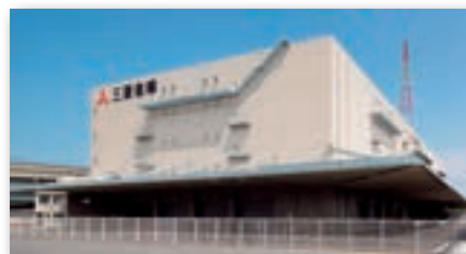
増築後の飛島配送センター
