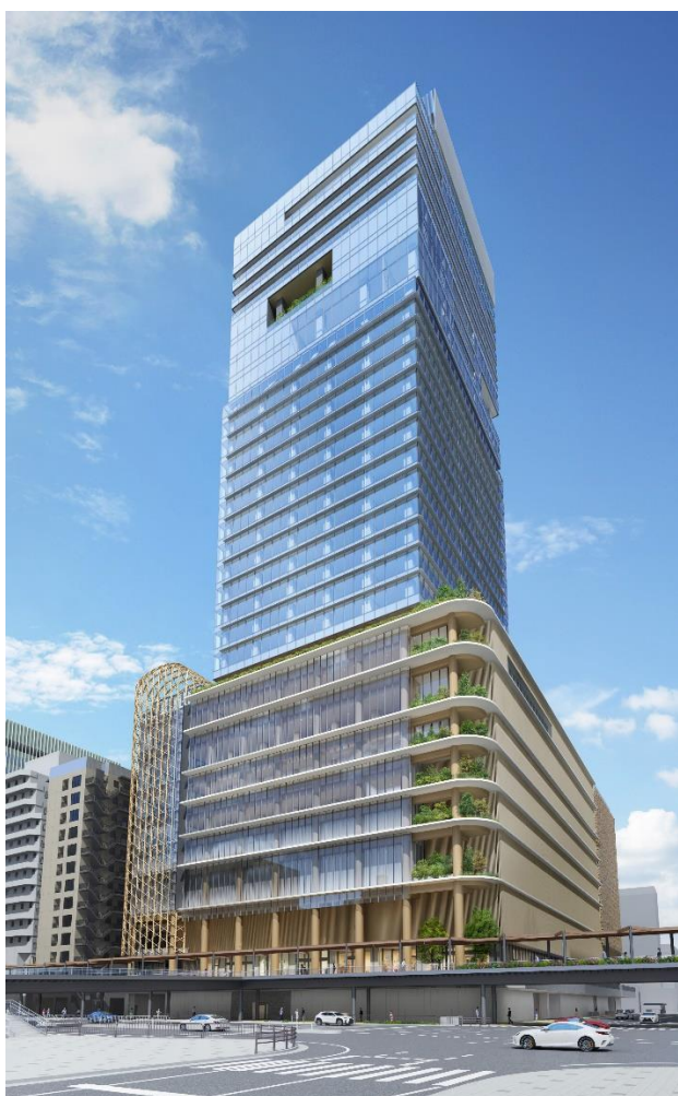
▲全体外観イメージ（南東より）
